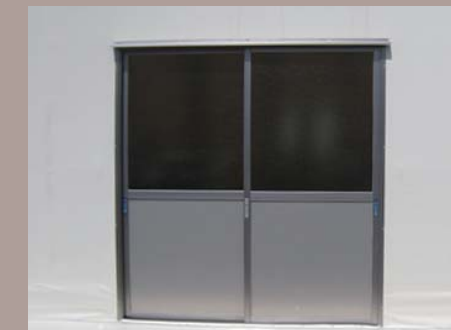
⑨ 出入口(引違いサッシ)
